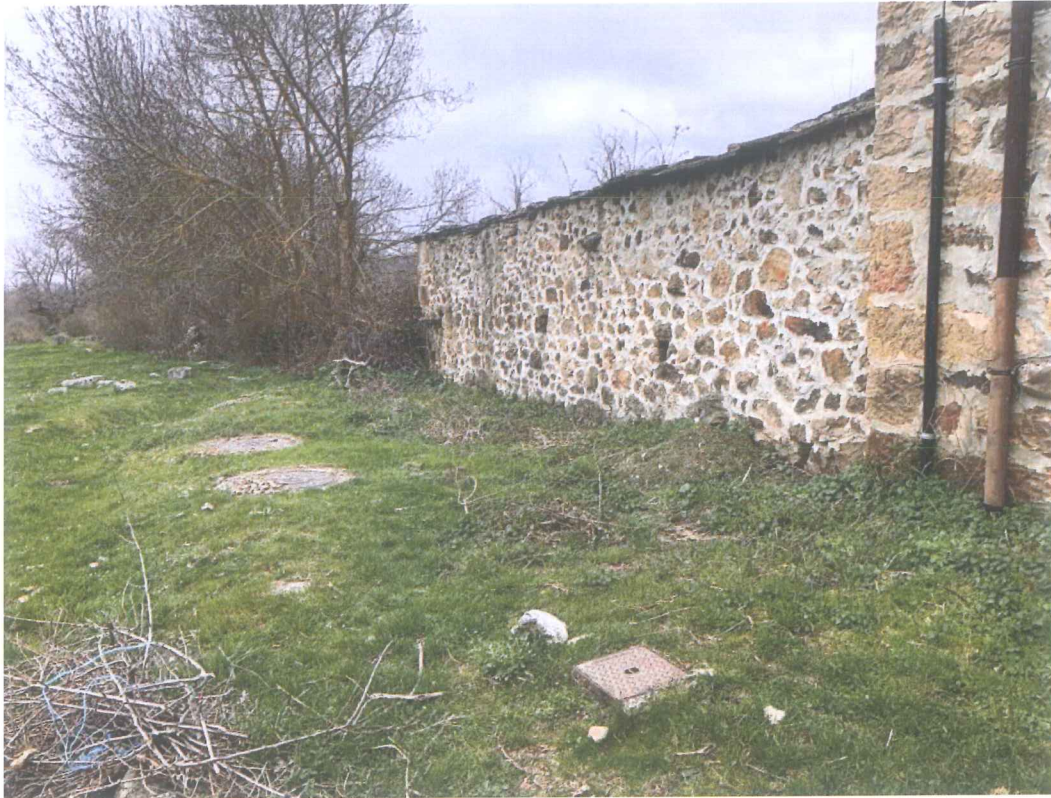
Vista de detalle de Registros de Red municipal de Saneamiento y acometida domiciliaria de abastecimiento y de telefonía, de vivienda colindante junto al lindero norte de la parcela objeto de modificación puntual
