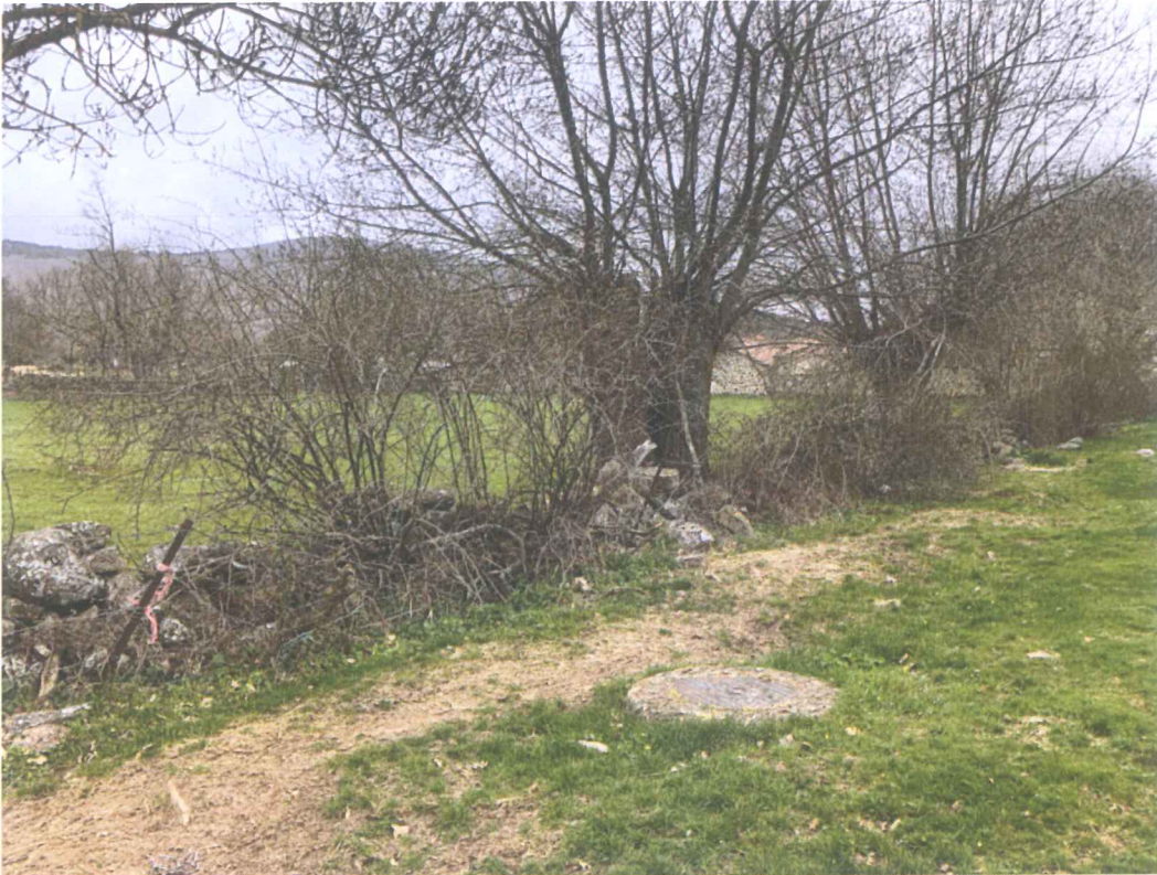
Pozo de registro de Red Urbanas de Saneamiento a pie de parcela Junto a su lindero norte
